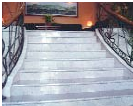
Como ejemplo de buena práctica en accesibilidad esta escalera dispone de zócalo lateral de protección y pasamanos a ambos lados, además de tabica. Debería incluirse una banda antideslizante en el borde de cada huella ya que se ha utilizado para los peldaños un pavimento demasiado pulido y deslizante
